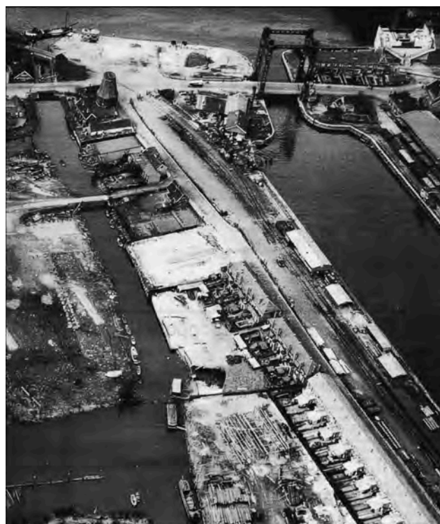
Op deze luchtfoto uit 1938 is de voormalige Spoorhaven aan de Weeskinderdijk te zien, nu een parkeerterrein. Rechtsboven is de verkeersbrug naar Zwijndrecht in aanbouw.
