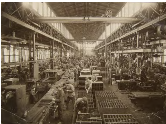
Dit deel van de fabriekshal laat personeel zien dat bezig is werk te verrichten aan verschillende onderdelen van brandkasten
